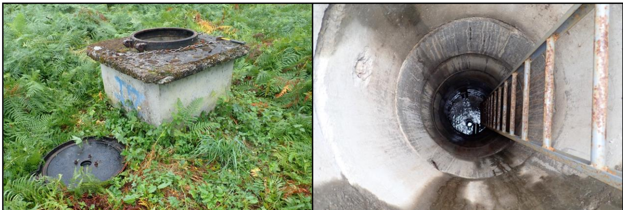
Le captage Verdier (22/09/20).
