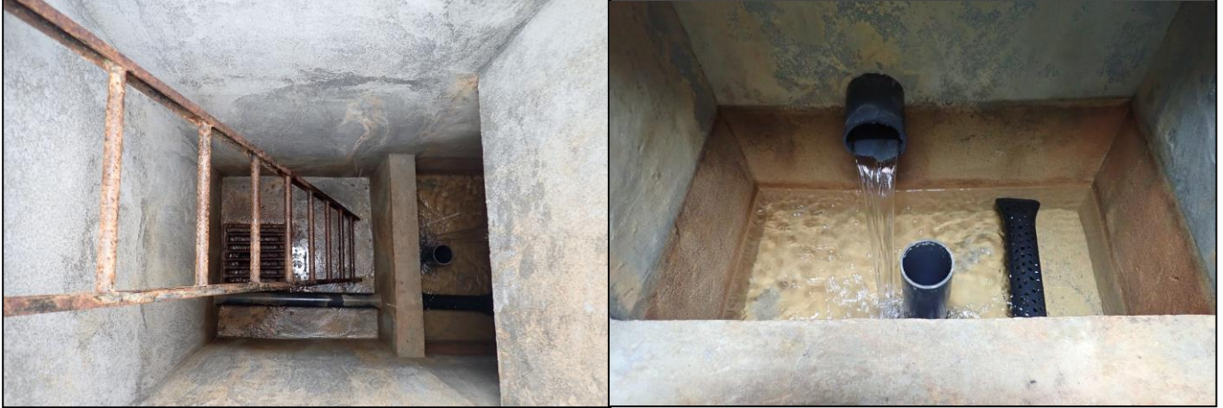
Intérieur du regard de captage Duprat (22/09/20).
